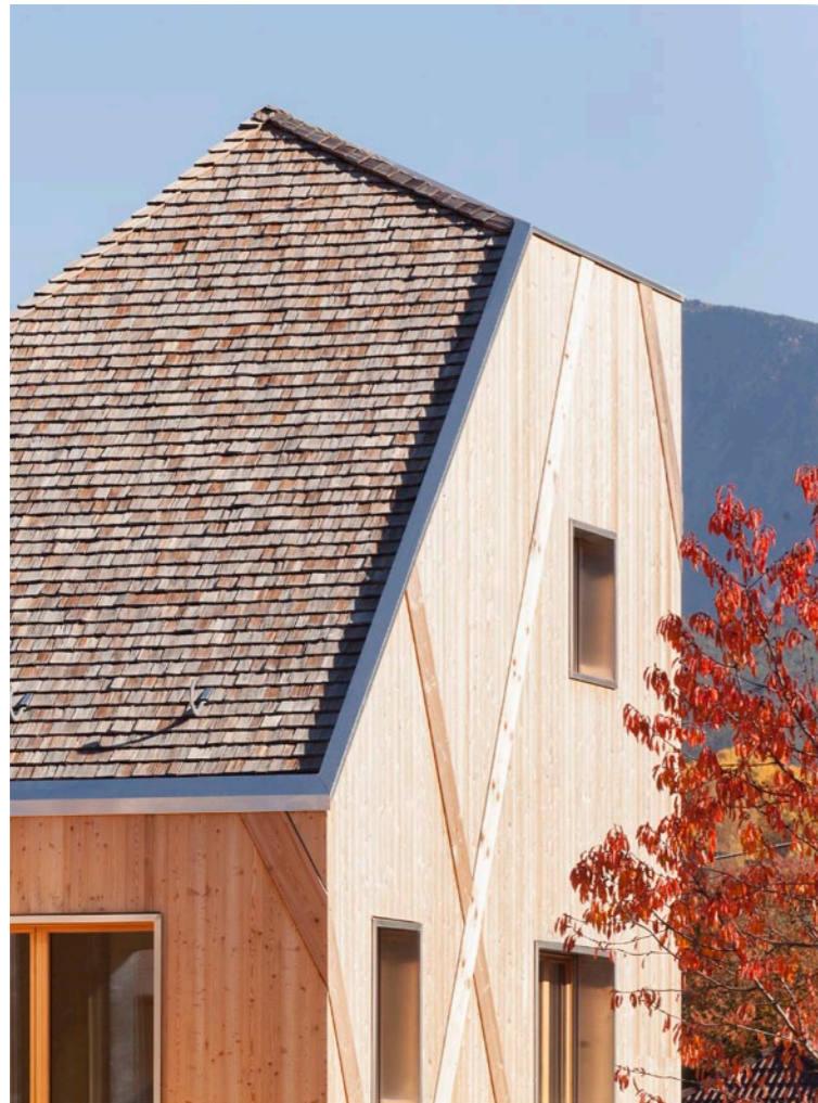
14C copertura in scandole lignee
