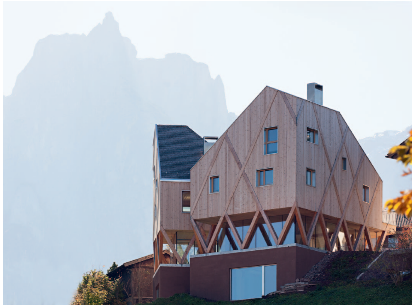
I2C vista nord-ovest
