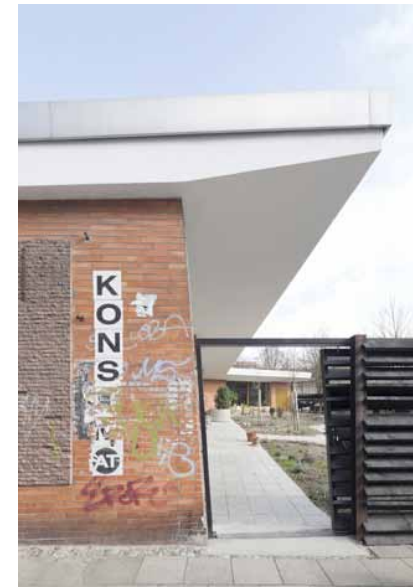
AUGUSTINUNDFRANKARCHITEKTEN HÜBNERSTRASSE, 2011 Courtesy augustinundfrankarchitekten Foto: Werner Huthmacher
